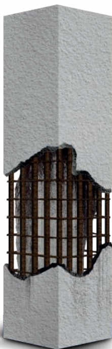
Φάση 2 Αφαίρεση του επιχρίσματος και της επικάλυψης του οπλισμού μέχρι να προκύψει υγιές σκυροδέμα
